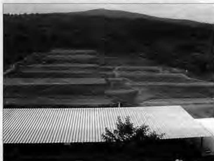
Vue générale d'un stand Silhouettes Métalliques. Stand de tir de Grasse.
